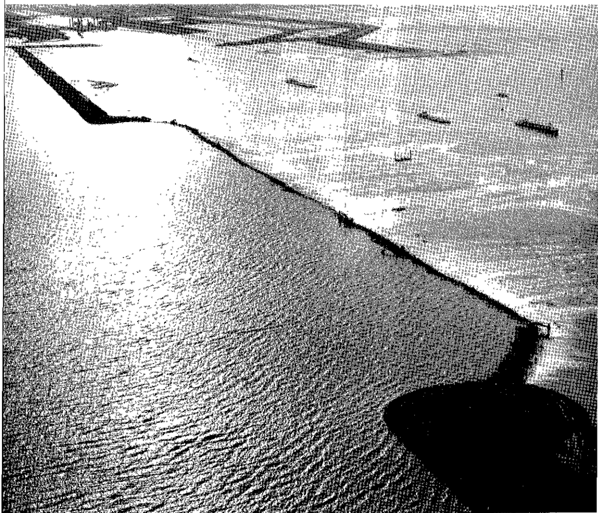
De getijstroom loopt door een bijna voltooide sluitkade; in dit geval de Westelijke Markie-zaatskade
